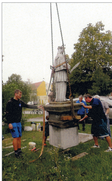
Příprava betonového základu pro osazení, kompletování památky
