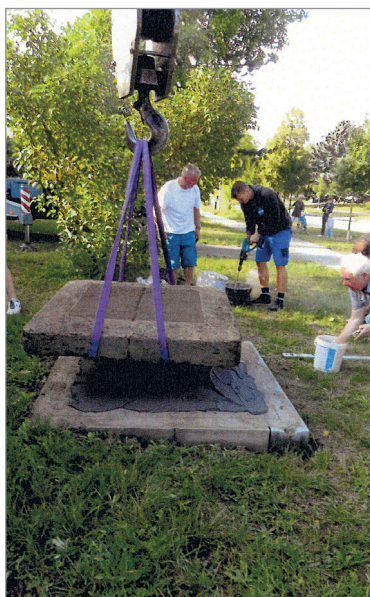
Příprava betonového základu pro osazení, kompletování památky
