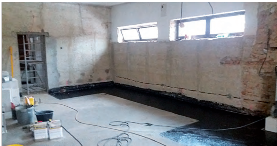
Příprava pro izolaci nové podlahy v předsálí
