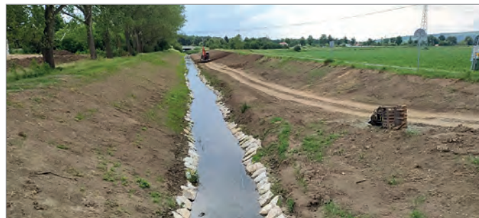
Pohled od mostu u „Nafty“ směrem k soutoku
