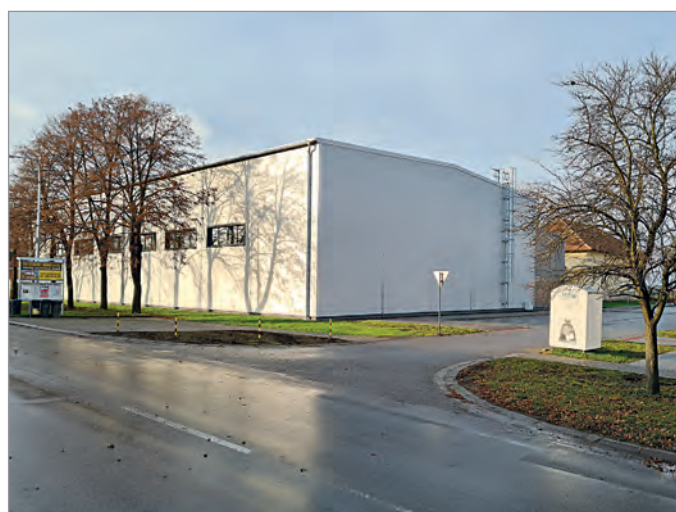
Nahoře: pavilon Základní školy Měnin Uprostřed: víceúčelové hřiště s umělým povrchem Dole: víceúčelová hala. Na protější straně: výsadba třešňové aleje
