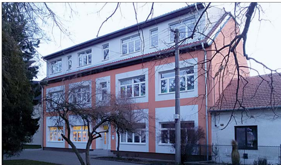
Školní budova po opravě střechy
